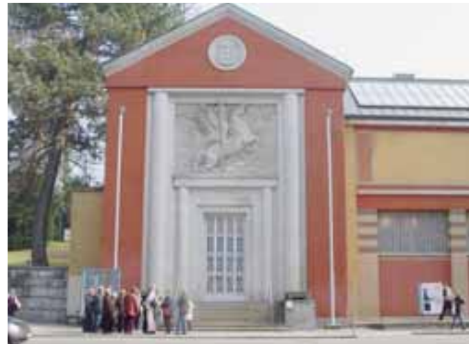
Ein überaus markanter Museumsbau : Das 1926 erbaute Musée des Beaux-Arts von La Chaux-de-Fonds.
